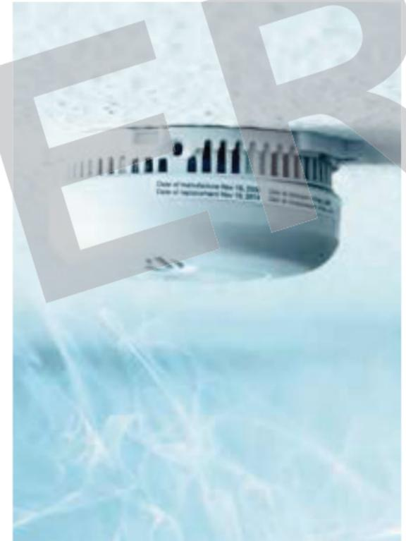
zehn Jahren nicht mehr zuverlässig arbeiten und das Gerät dann in jedem Falle ausgetauscht werden muss. Oft halten auch die verwendeten Batterien nicht über die ganze Lebensdauer. Alleine schon die Wahl des richtigen Rauchmelders und die richtige Montagetechnik bergen viele Fehlermöglichkeiten mit großen Wirkungen in sich.
